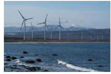
風木風力発電所
